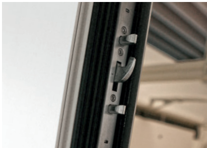
Mehrfachverriegelung mit integrierten Haken und Bolzen
